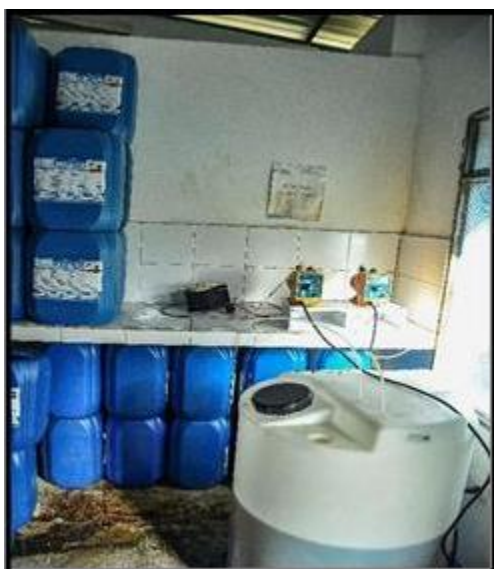
Figura 27. Coagulación PTAP, Autor, 2022.
