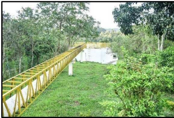
Figura 39. Conducción tratamiento secundario, Autor, 2022.
