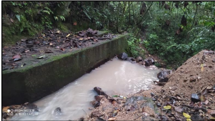
Figura 23. Captación lateral Quebrada El Pueblo, Autor, 2022.
