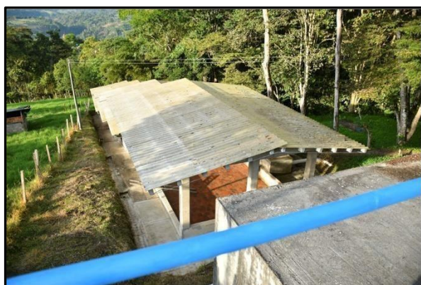
Figura 37. Lechos de secado PTAP, Autor, 2022.
